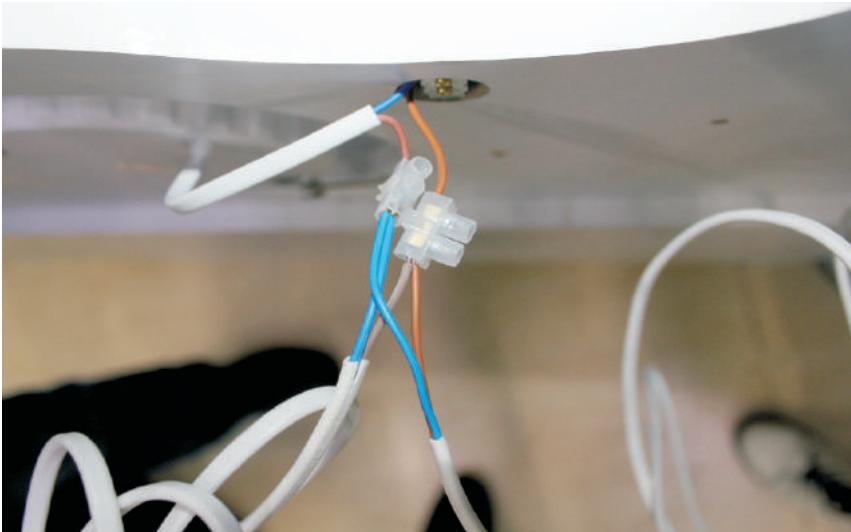
Шаг 10. Второй провод подключить к клеммным колодкам второго светильника.
