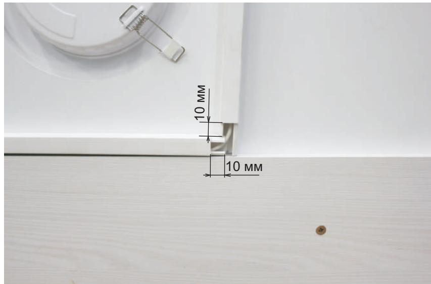
Шаг 19. Установите уголки. Они должны закрывать контакты выключателей.
