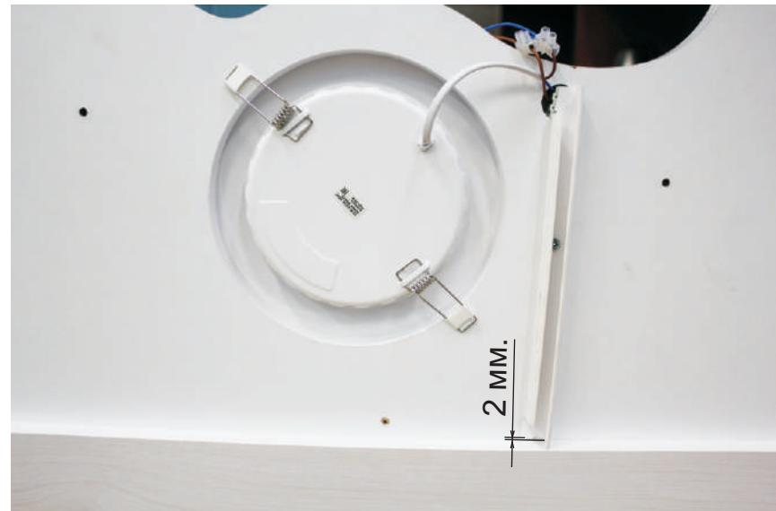
Шаг 13. Между ними установите длинный кабель-канал на саморезы 65 с зазором 2 мм от щита ЛДСП.
